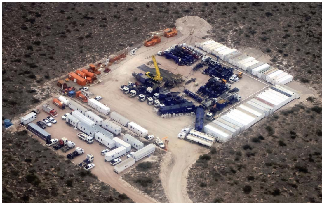
Vista aérea de una locación de exploración shale en la formación Vaca Muerta. Foto: YPF.
