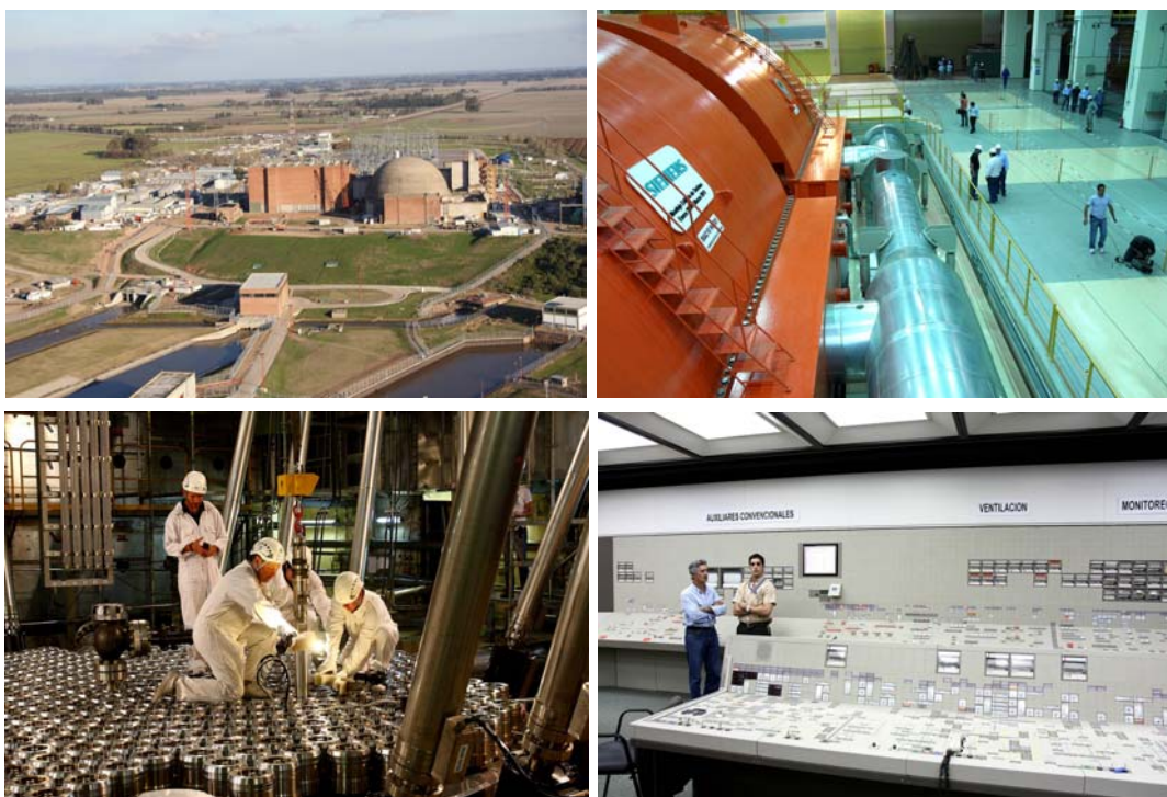
Imágenes de la Central Nuclear Atucha II. Fuente: Nucleoeléctrica Argentina S.A.
