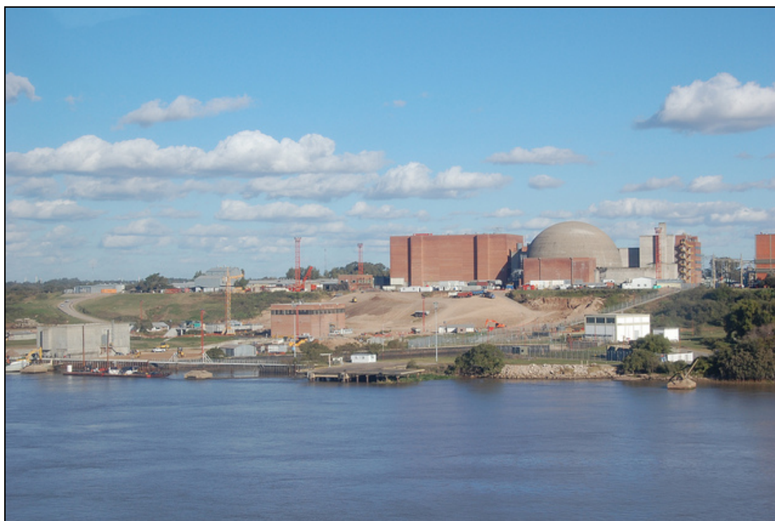
Vista panorámica de la Central Nuclear Néstor Kirchner (ex Atucha II).
