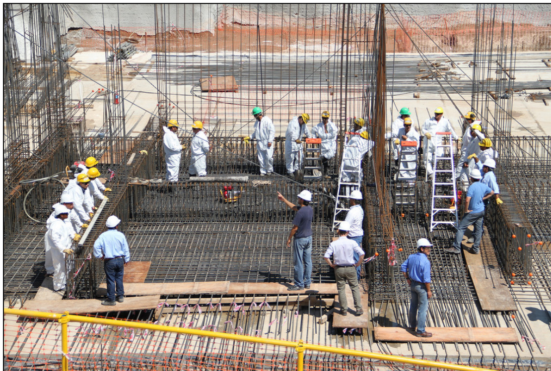
Inicio de las obras civiles del edificio de oficinas del Proyecto CAREM-25. Foto: Comisión Nacional de Energía Atómica, Febrero de 2014.
