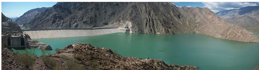
Central Hidroeléctrica Los Caracoles, provincia de San Juan. Foto: Gobierno de San Juan, 2009.
